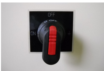
Interrupteur 950 V
