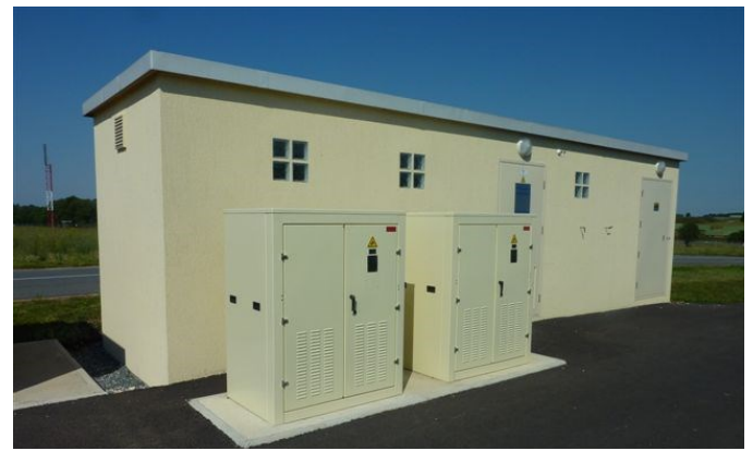
Base aérienne d'Avord, alimentation bâtiments
