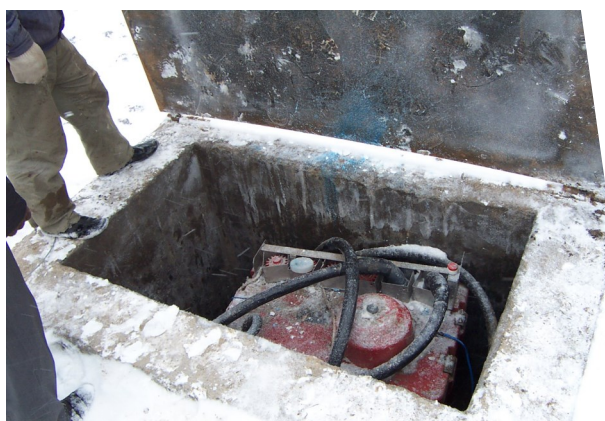
Routes, Chine, alimentation éclairage
