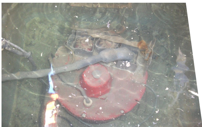
Ferroviaire, France, alimentation éclairage tunnel
