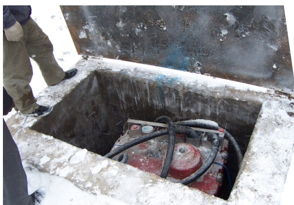
Routes, Chine, alimentation éclairage
