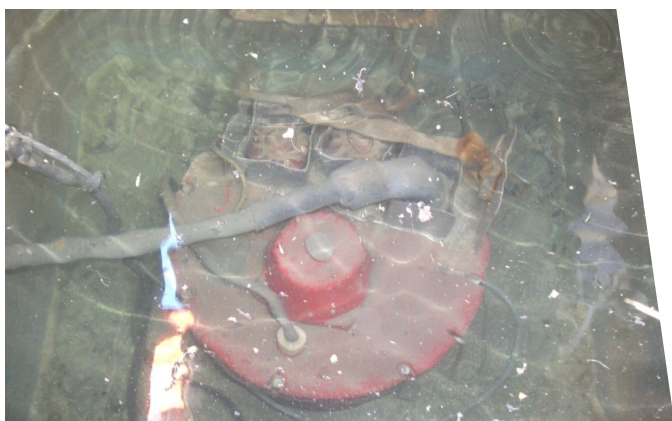
Ferroviaire, France, alimentation éclairage tunnel
