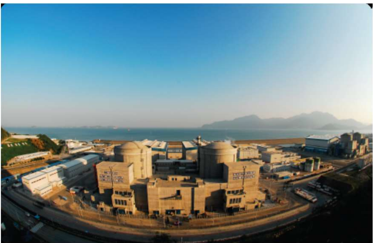
GUANGDONG, CHINE – Eclairage du chantier et des parcs centrale nucléaire
