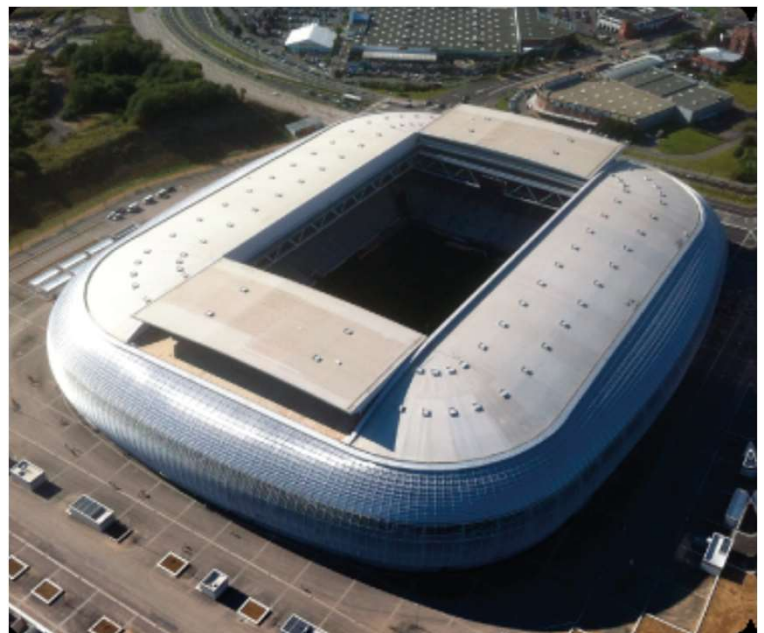
LILLE, France – Eclairage de l'accès au stade
