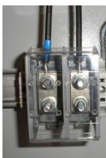
Raccordement 950 V sur bornes protégées par un capot transparent, pour câble U1000 R2 V ou équivalent de 6 à 25 mm<sup>2</sup>.
